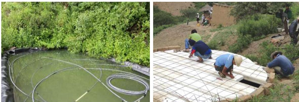
Foto N° 3 y 4. Construcción de estanques para cosecha de agua (FUENTE: ISA BOLIVIA 2017)
